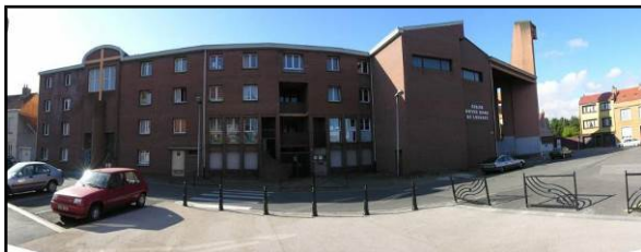
Immeuble Carnot dans le secteur A
