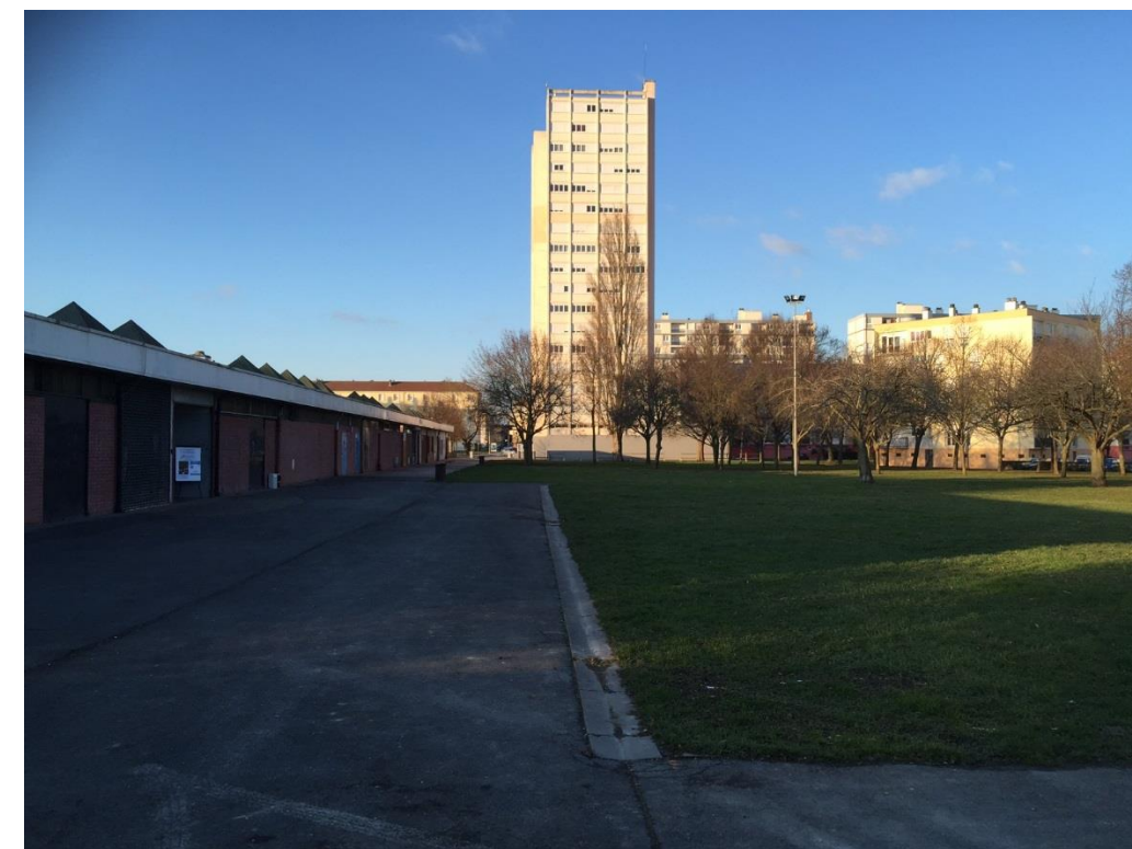
Allée piétonne longeant le CCial et desservant le CSC
