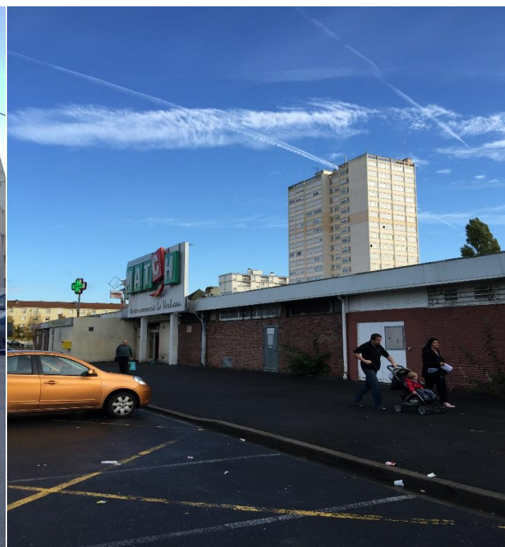
Entrée principale du Centre Commercial
