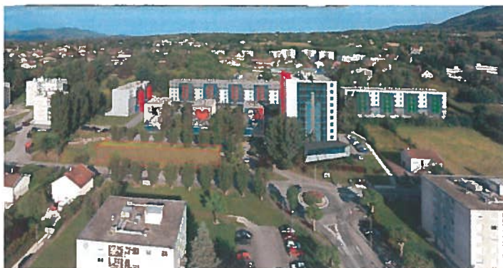
Document 8 : vue projetée après la démolition
