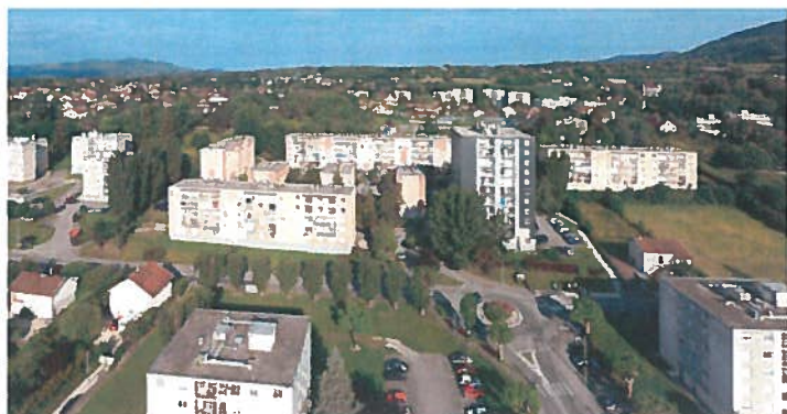
Document 7 : Vue avant la démolition
