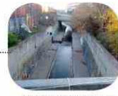
Ruisseau canalisé enris de côté
